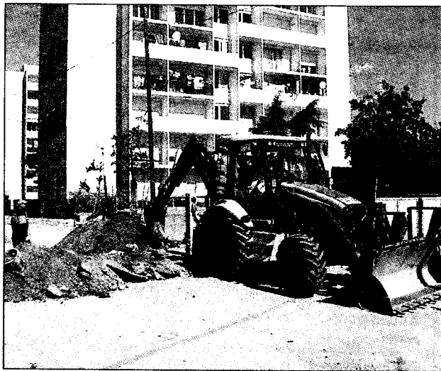
LUNDI, SUR LE CHANTIER DU GPV. Les engins d'Eurovia ont repris les travaux.
